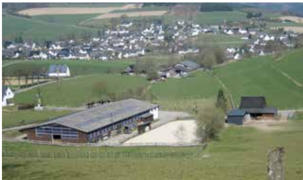
Blick auf Reitplatz, Reithalle und Stallungen des RV St. Hubertus Wennetal
