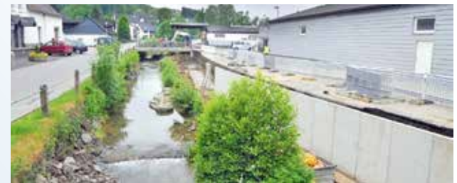
Erster Bauabschnitt entlang der Sormeckestraße
