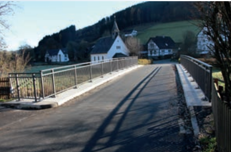
Sanierte Brücke in Sallinghausen
