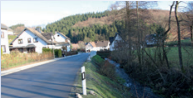
Ausgebaute Straße Zum Hohenstein
