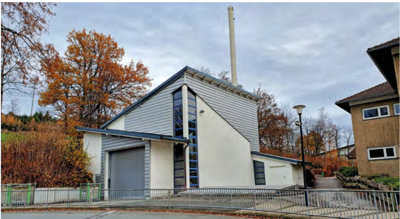
Holzheizwerk am Esloher Schulzentrum
