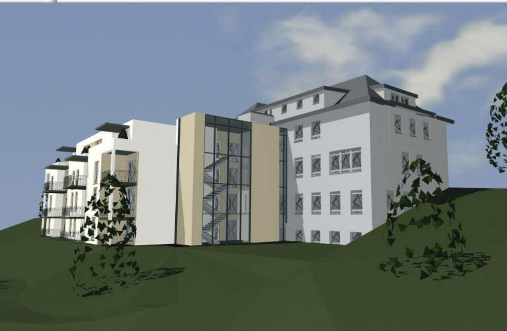
*Schematische Außenansicht der Erweiterung des Kurhauses aus Richtung des Schwimmbades. Das zentrale Treppenhaus verbindet die Gebäudeteile und ein neuer Aufzug schafft Barrierefreiheit bis in den Kurpark hinein.*
