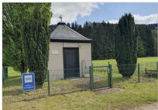
Links unten: Pumpstation Benders Wiese, hier wird das Trinkwasser aus der Quelle in die Leitung Richtung Eslohe gepumpt
